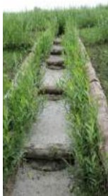
Los sistemas de drenaje realizados con bioingeniería son elementos vivos
